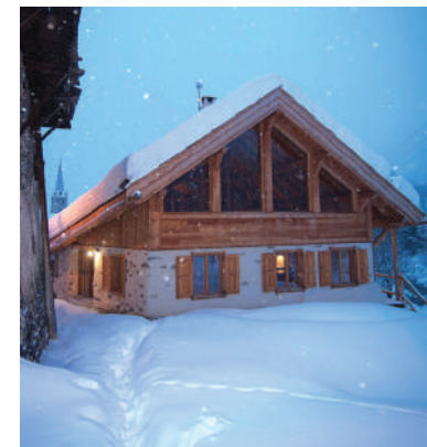
Réalisation et maîtrise d'œuvre tous corps d'État : Chalets Bayrou Maçonnerie : Colombar
